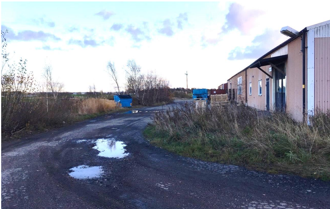
Figur 7. Svag lutning mot diket till vänster i bild. Stuprör med utkastare till gräsbevuxen yta.
